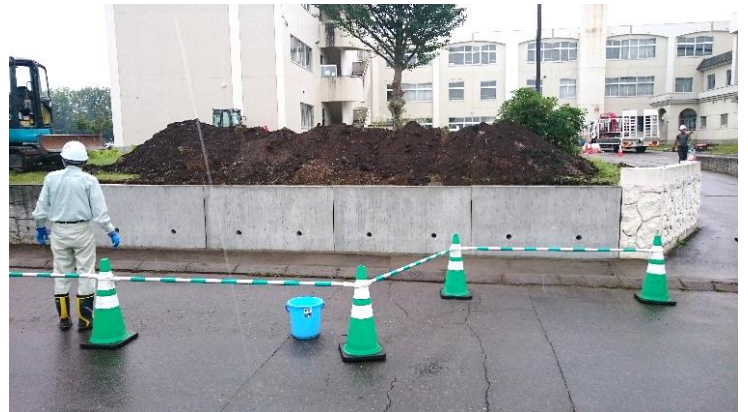
劣化が激しかった校門横のブロック塀を、安全管理のための修復工事が行われました
